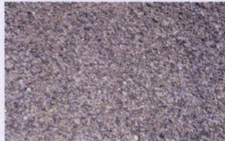
碎石を施した施工表面
