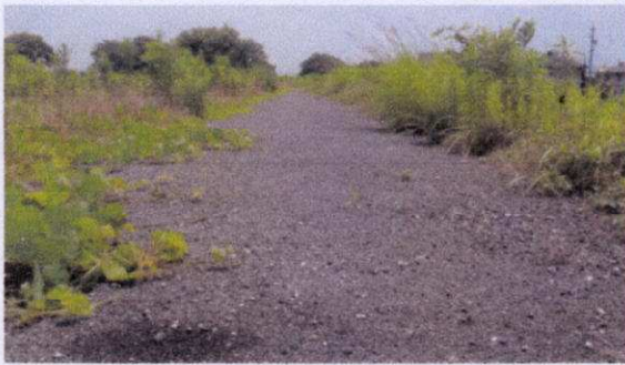
河川堤防施工(三年経過)
