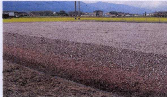
宅地施工(六ヶ月経過)
